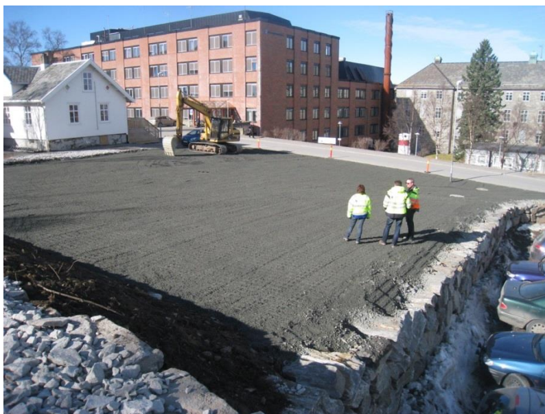
Illustrasjon: Stopp- og snuplass for buss ved sykehuset under arbeid. Foto: Alstahaug kommune
