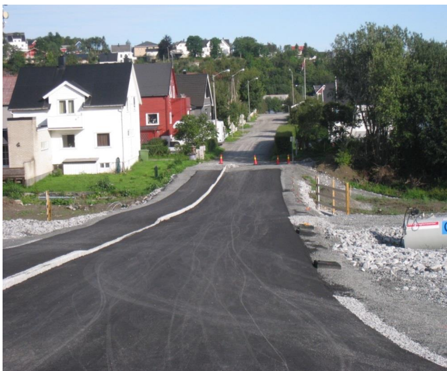
Illustrasjon: Arbeidet med etablering av fortau ved Sandnes skole er i gang.
