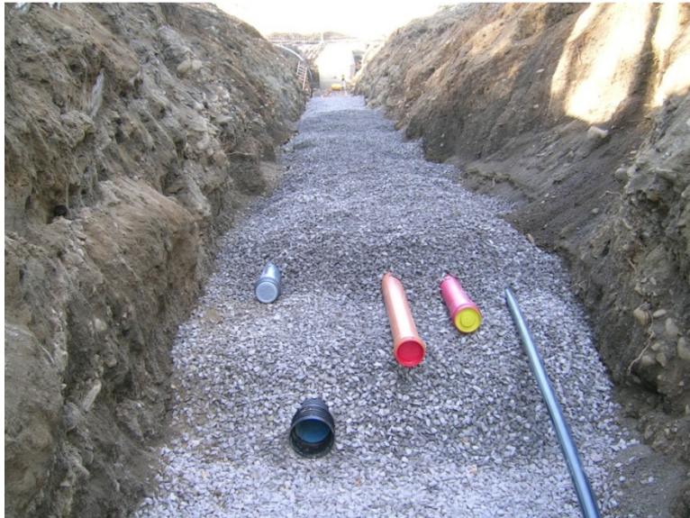
Figur 6.3.3 Typisk VA – grøft
